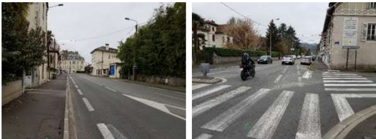
Figure 33 : marquages au sol de l'avenue Henri IV jusqu'à la rue de la croix du prince
