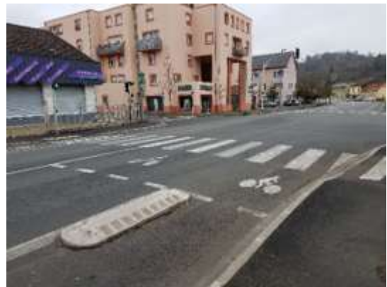
Figure 35 : bande cyclable séparée par des plots bétons de chaussée auto devant le collège E. Gabbard
