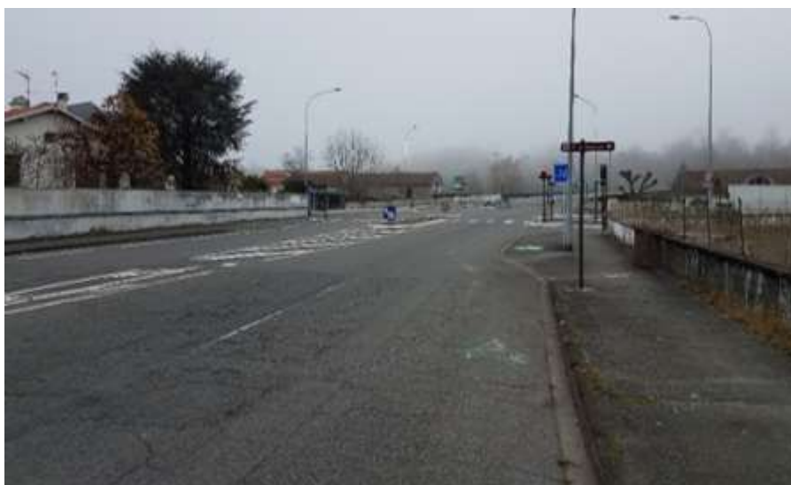
Figure 21 : la bande cyclable de l'avenue des vallées en direction du pont d'Espagne n'est pratiquement plus visible
