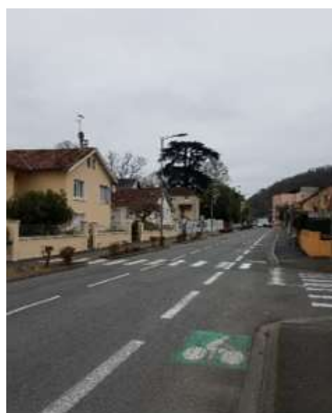
Figure 32 : aménagement de la rue Ollé Laprun : Piste cyclable séparée en direction du centre de Jurançon et bande cyclable en direction de l'avenue Henri IV
