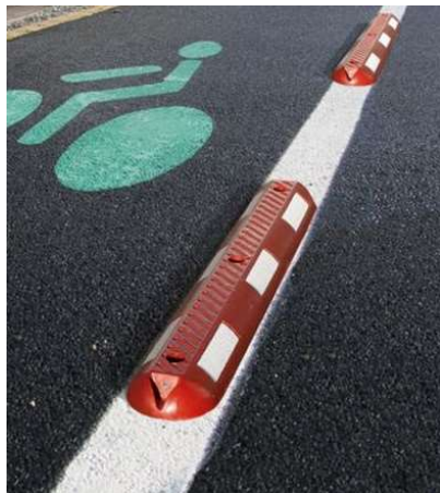
Figure 29 : exemples de protection des bandes cyclables vis-à-vis de la circulation automobile
