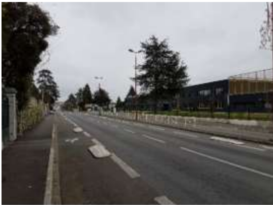
Figure 35 : bande cyclable séparée par des plots bétons de chaussée auto devant le collège E. Gabbard
