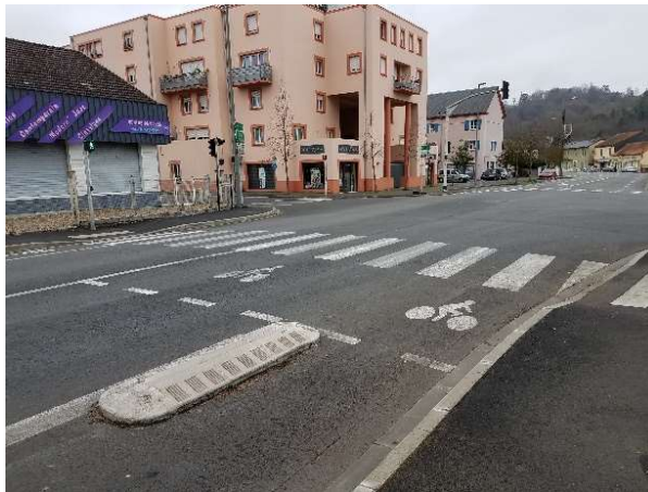
Figure 29 : exemples de protection des bandes cyclables vis-à-vis de la circulation automobile
