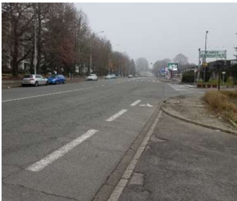
Figure 20 : arrêt de la bande cyclable de l'avenue des vallées au croisement avec la rue Massenet
