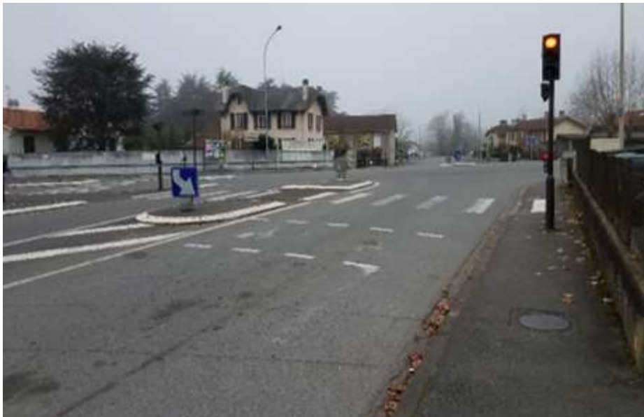
Figure 24 : SAS vélo pratiquement non identifiable par manque d'entretien du marquage au sol sur la rue Amédée Roussille
