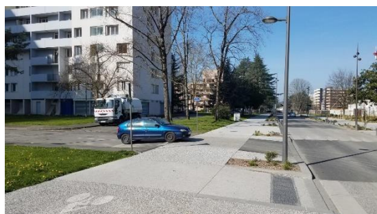
Figure 14 : Exemple de trottoir traversant de l'avenue Saragosse
